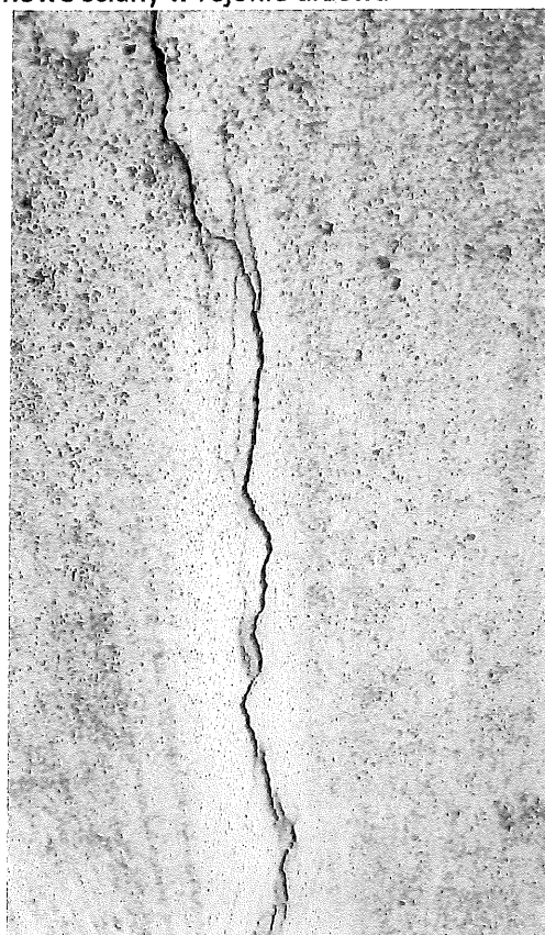
Zdjęcie nr 8 Pęknięcie pionowe ściany w rejonie drzewa
