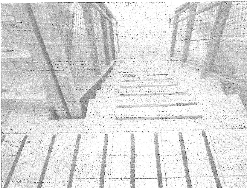
Fot. 3. Paski antypoślizgowe naklejone na okładzinę ceramiczną schodów.
