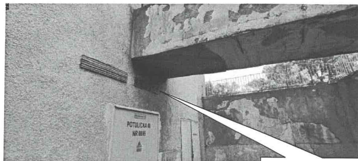
WIDOK OPARCIA KŁADKI NA ŚCIANIE TRAFOSTACJI
