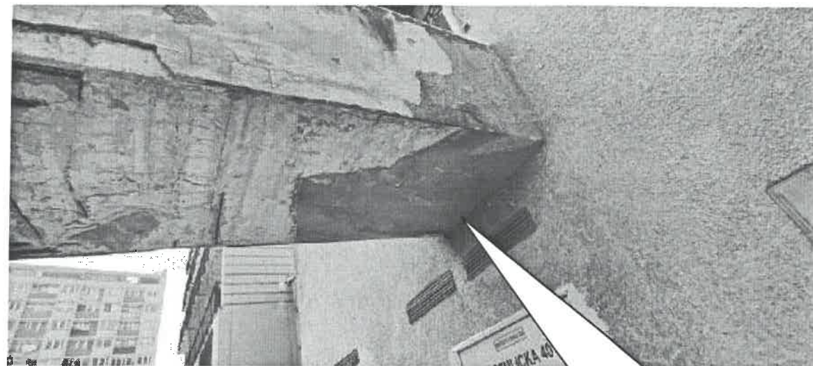
WIDOK OPARCIA KŁADKI NA ŚCIANIE TRAFOSTACJI
